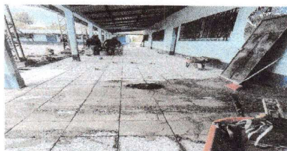
Foto 6: Sustitución de piso en proceso.
