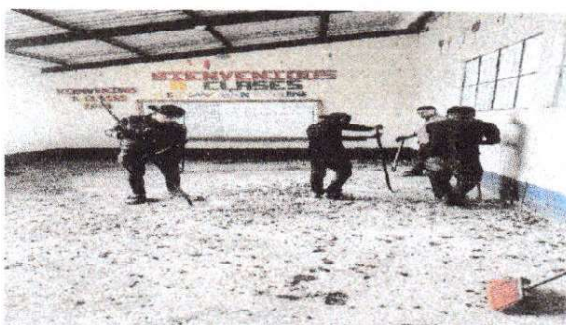
Foto 3: Sustitución de piso.
