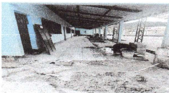
Foto 5: Sustitución de piso en proceso.
